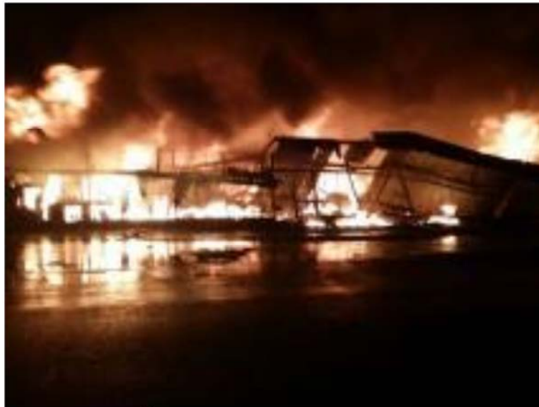
Imagen 2-24: Incendio en Mueblería de Hato Tejas (2014)
