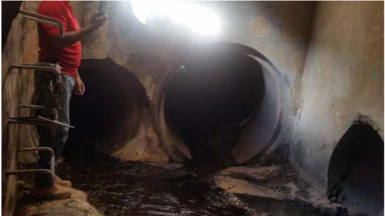
Figura #01 Condición Existente Poceto "Manhole"
