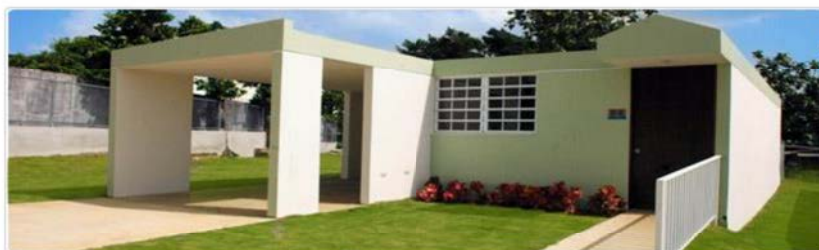
Imagen 1-1: Unidad de Cemento Construida en la Comunidad El Volcán
