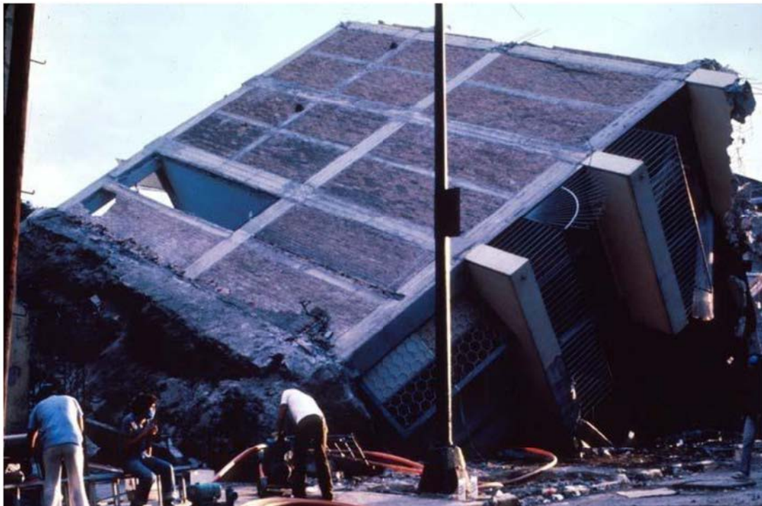
Imagen 2-14: Efecto de Licuefacción Sobre Edificio en México
