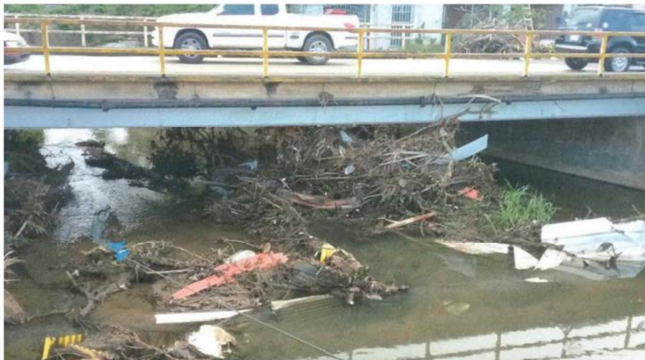
Imagen 2-16: Escombros Arrastrados a los Cuerpos de Agua por Eventos de Lluvias Intensas
