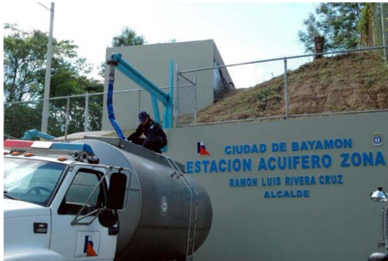
Imagen 2-4: Estación Acuífero Zona Sur, Bo. Dajaos
